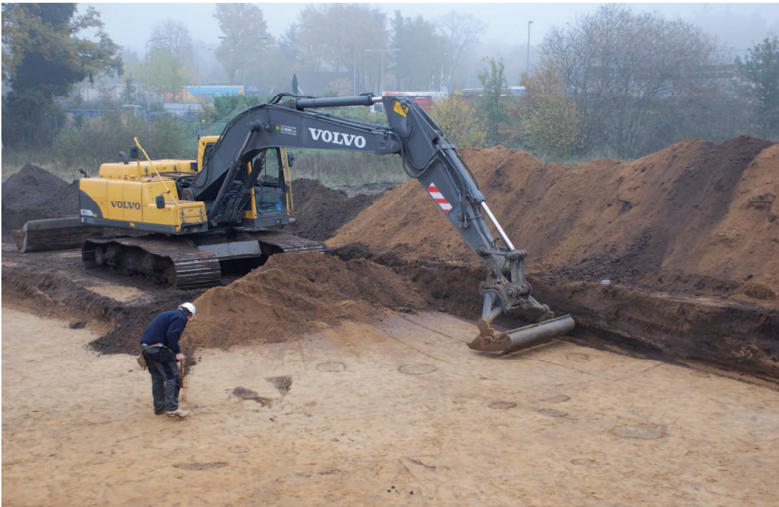
Figuur 3. De aanleg van het vlak in werkput 16 met behulp van een graafmachine met schaaftak.
